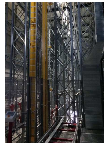
Vollautomatisches Hochregallager kurz vor Inbetriebnahme
